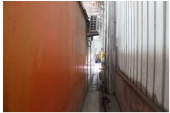
探伤室西墙外
