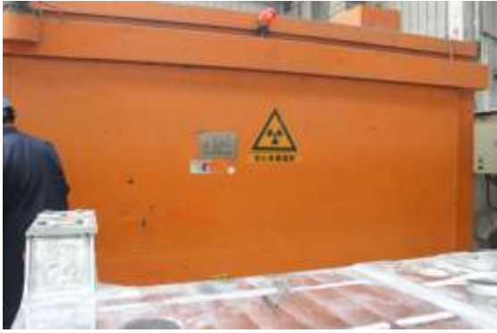
探伤室大防护门
