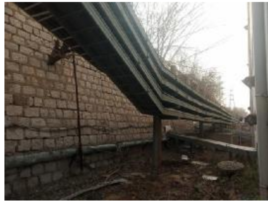
110kV II 配电装置南侧
