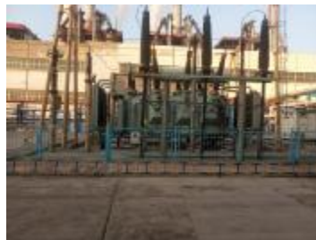
现有 220kV 变电站变压器区南侧
