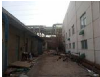
现有 220kV 变电站配电装置东侧
