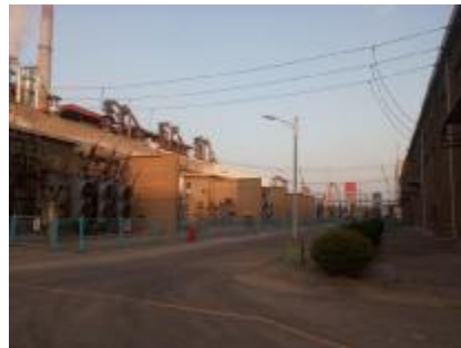
110kV I 配电装置北侧
