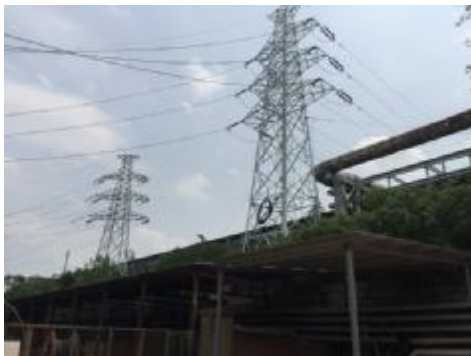
图 4 改造的 110kV 终端塔
