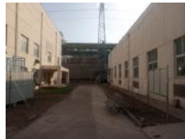
现有 220kV 变电站配电装置西侧
