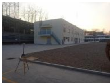
110kV I 配电装置西侧
