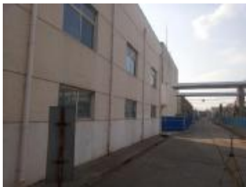
现有 220kV 变电站配电装置北侧
